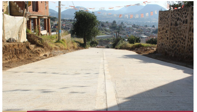
15 CONSTRUCCIÓN DE CAMINO A ALMANDRALES
