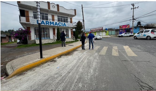
13 CONSTRUCCIÓN DE GUARDIANES Y BANQUETAS AV. RICARDO FLORES MAGÓN
