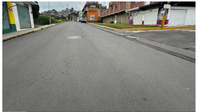
17 CONSTRUCCIÓN DE CAMINO A TEZOPILO
