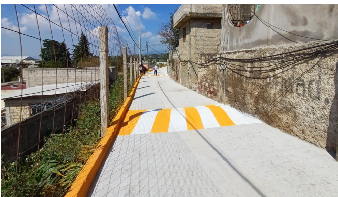
14 CONSTRUCCIÓN DE PAVIMENTO HIDRAULICO EN CALLE PROL. CRUZ DE MAYO
