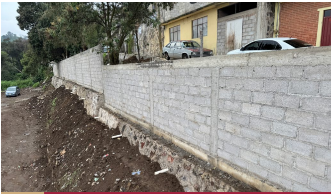
11 CONSTRUCCIÓN DE MURO DE CONTENCIÓN EN CALLE CAMINO VIEJO A TEZOPILO
