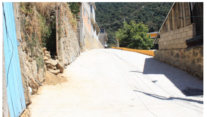
18 CONSTRUCCIÓN DE PAVIMENTO HIDRAULICO EN CALLE MIRADOR
